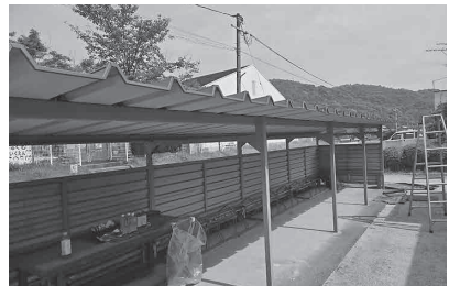
屋根の塗装まで完璧 (西大寺支部)
