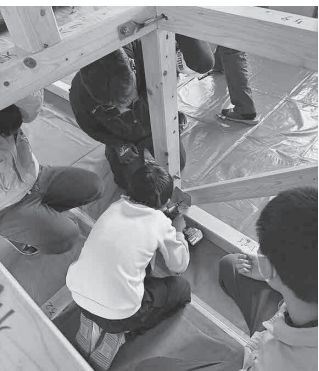
ちびっ子大工さん施工中
