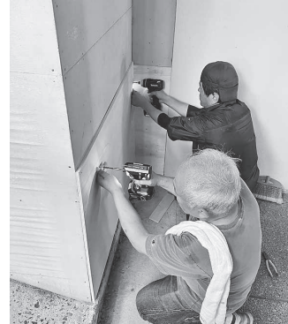
壁の補修もお手の物(都窪支部)
