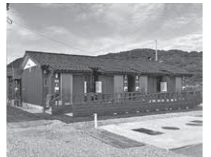
完成した仮設住宅
