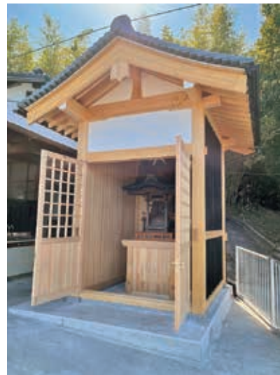
稻荷神社 覆屋 西大寺支部 野崎 洋介 (大工)
