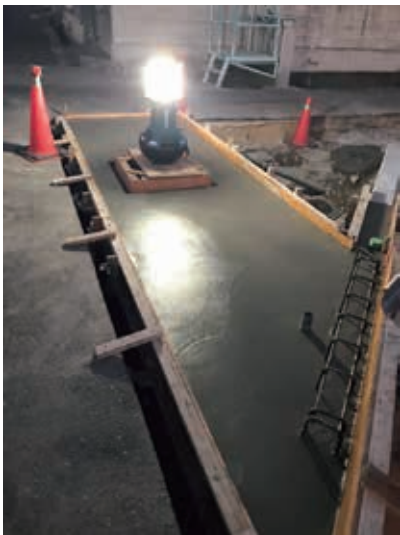
道路拡幅工事 玉島支部 藤岡 幸夫 (土工)
