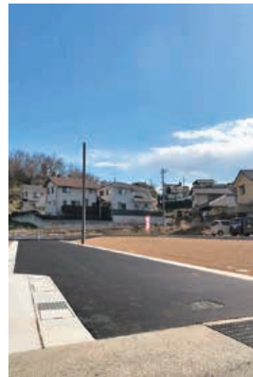
柏島造成工事
