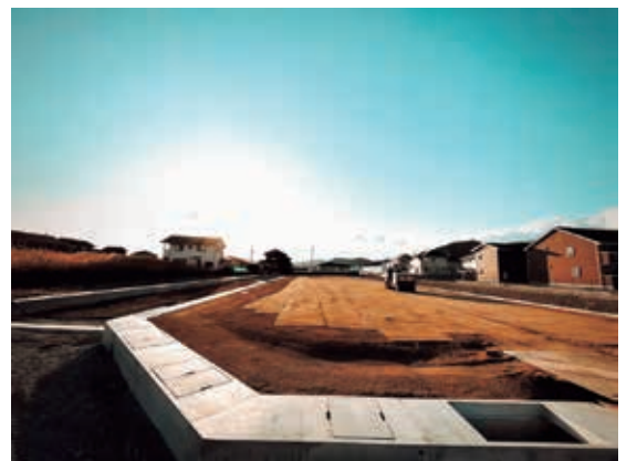
造成工事 玉島支部 和田 健歩 (土工)
