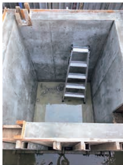
工場内工事 玉島支部 入江 真 (土工)
