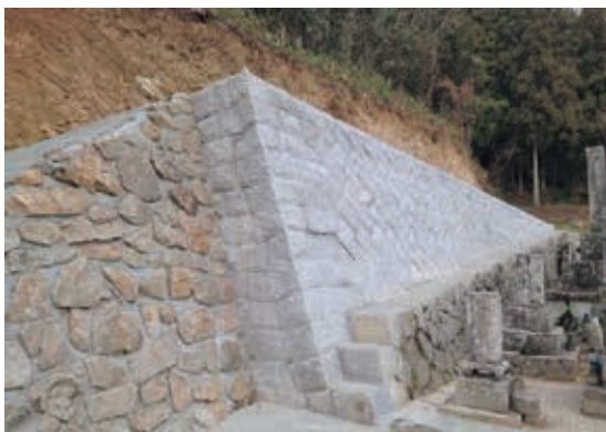
佐藤家墓地土工事 高梁支部 倉野 克志 (土工)
